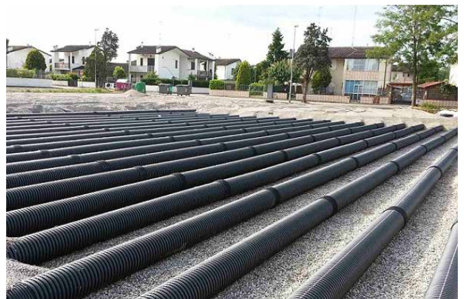
Die Wellverbundrohre mit Durchmessern bis zu 1.800 mm kommen bei nachhaltigen Infrastruktur-Projekten zum Einsatz.
